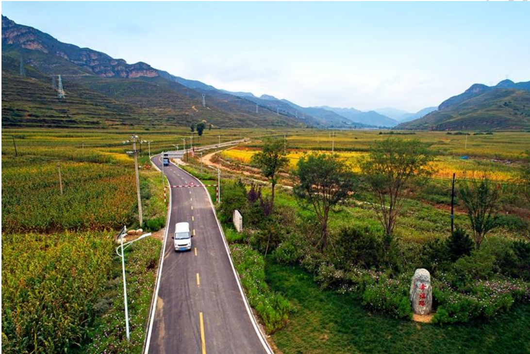
图 12: 幸福路竣工通车实景
